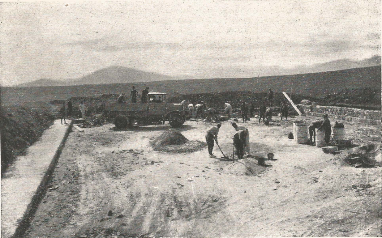
Piscina en construcción.—Cabida un millón de litros
