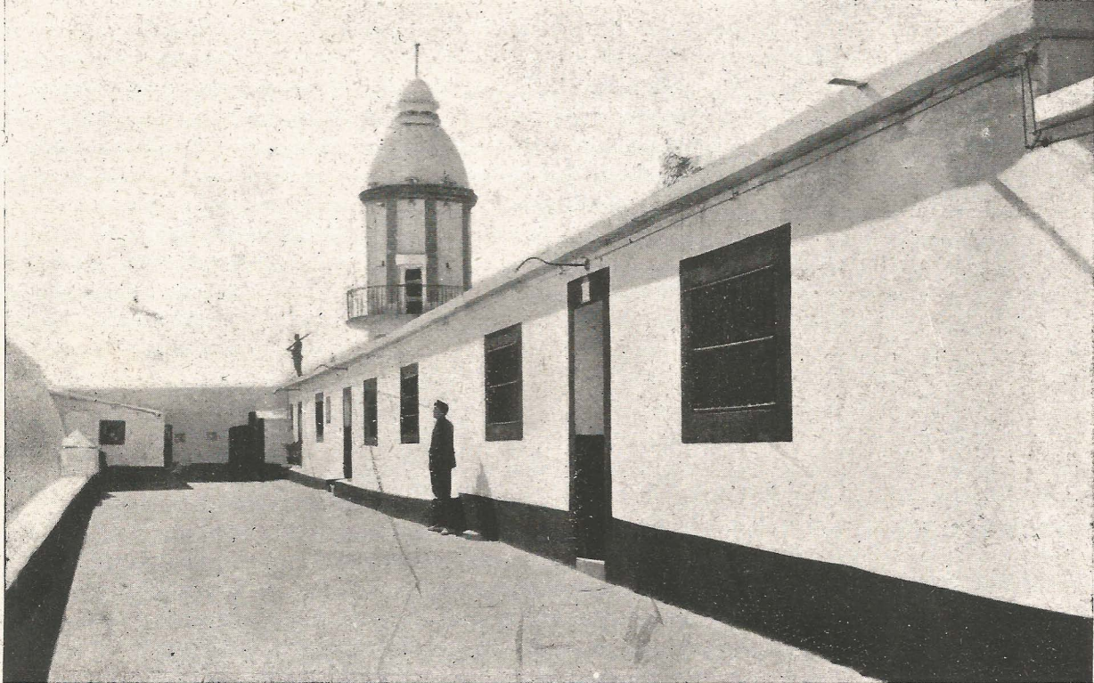
Pabellones destinados a la «Sección de trabajos»
