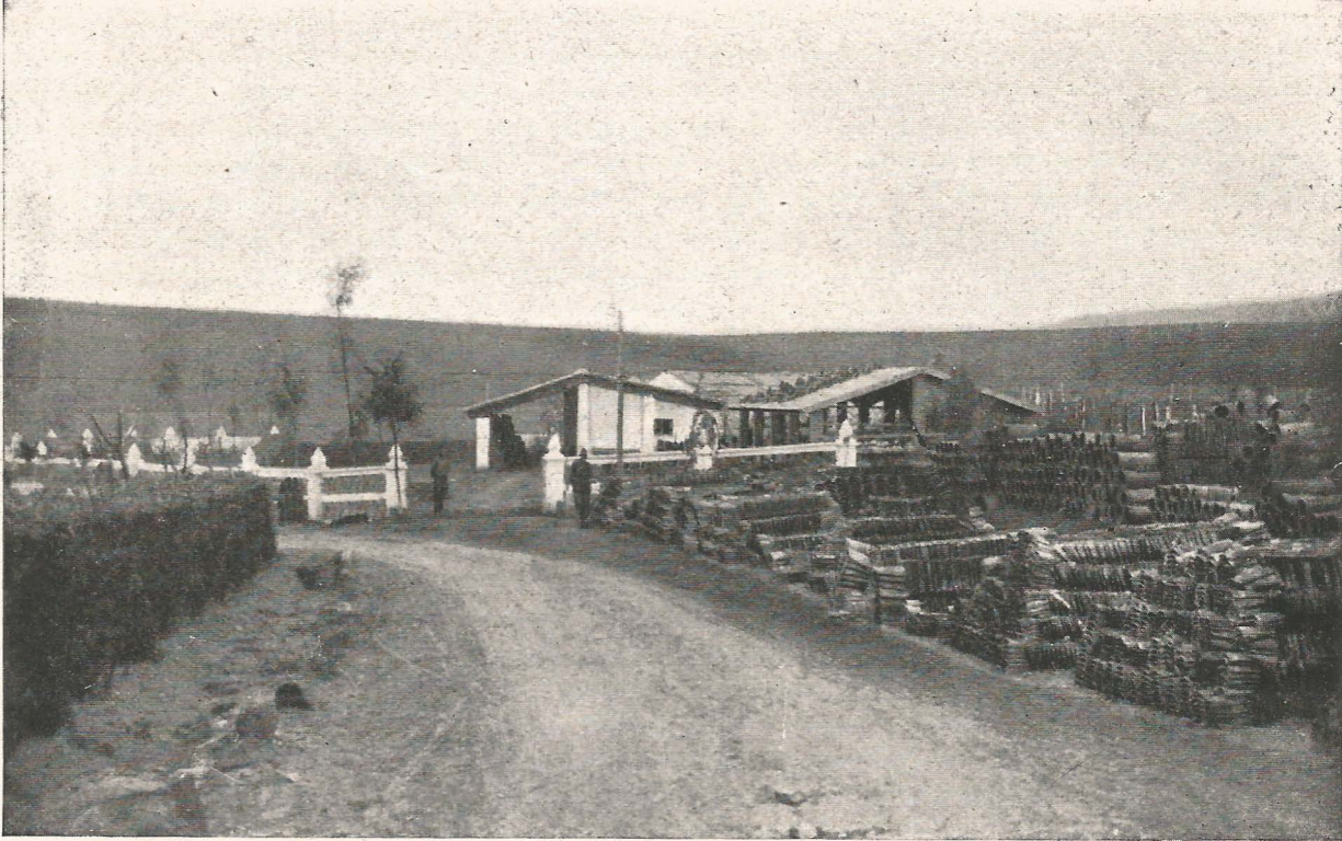
Cerámica.—Barracones en construcción, para instalación de maquinaria
