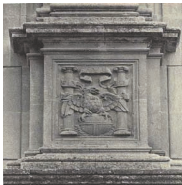
Columnas del Palacio de Carlos I
